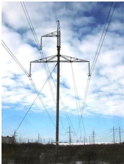
Рисунок 2.9 – Залізобетонна проміжна опора повітряної лінії 330 кВ
