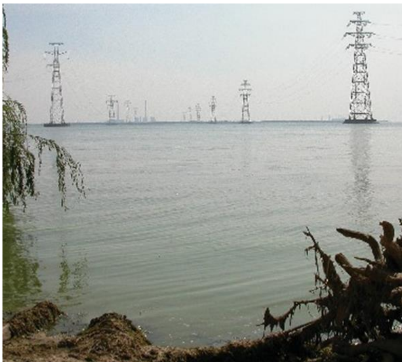
Рисунок 1.10 – Передача енергії повітряними лініями електропередач напругою 750 кВ через Каховське водосховище (Україна)
