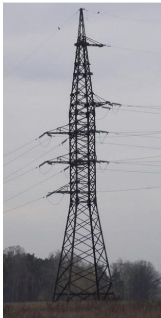
б) відпайкова опора лінії 110 кВ
