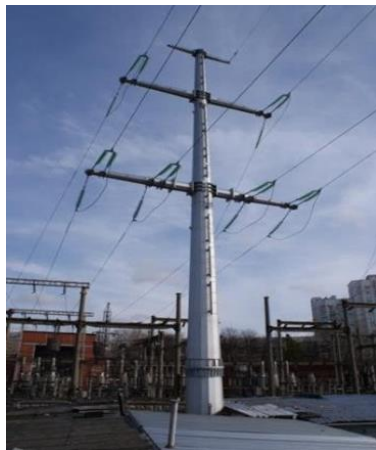
Рисунок 2.11 – Анкерна багатогранна металева опора лінії 110 кВ
