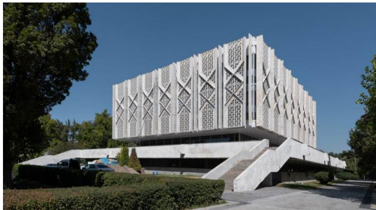
3.7.3-rasm. Toshkent modernizmi: Oʻzbekiston tarixi davlat muzeyi
