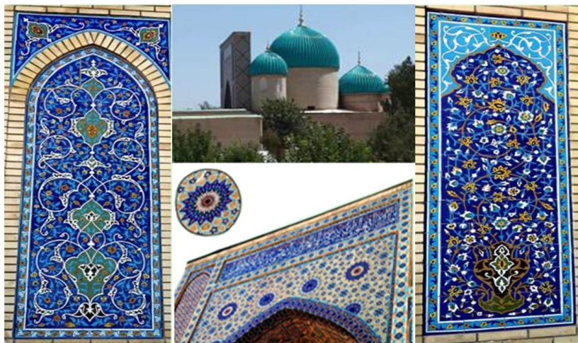
3.5.3-rasm. Toshkentdagi Zangi Ota maqbarasining naqshu-nigorlari (N.V. Gilmanova bo'yicha).
