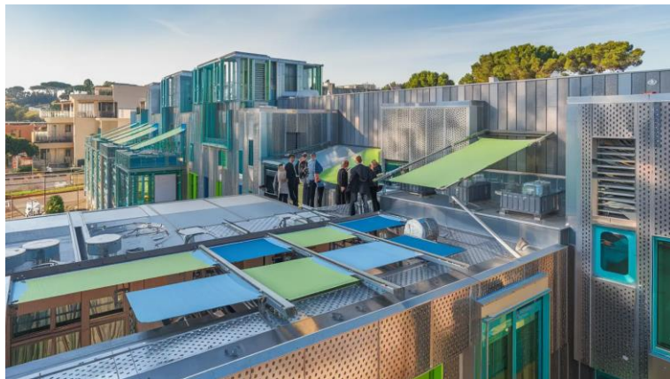
7.7. Energiya tejamkor binolar.
